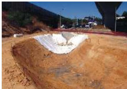
Já começou a empreitada de regularização da Vala de Corroios junto ao viaduto da Refer. A intervenção consiste em aterrar os taludes, regularizar a vala mantendo o traçado, revestir os taludes com geotextil e efectuar o enrocamento de forma a ficarem consolidados. Vai ainda ser reparada a valeta em betão que tinha ruído.
