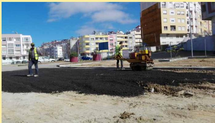
Requalificação do espaço do Parque de Autocaravanismo com a colocação de lancil e lajetas, britado de alcatrão nos acessos e saibro nas áreas de estacionamento, instalação caleiras para a plantação de árvores e iluminação.
