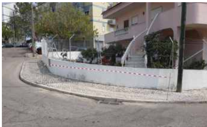
Reparação de calçada na rua Reinaldo Ferreira, Qta. de S. Nicolau
