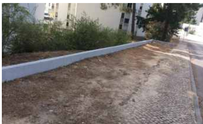
Pintura de muros na rua Eça de Queirós, Miratejo
