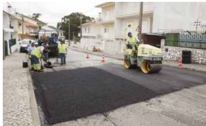
Lombas para redução da velocidade na Av. Infante D. Henrique, Vale de Milhaços
