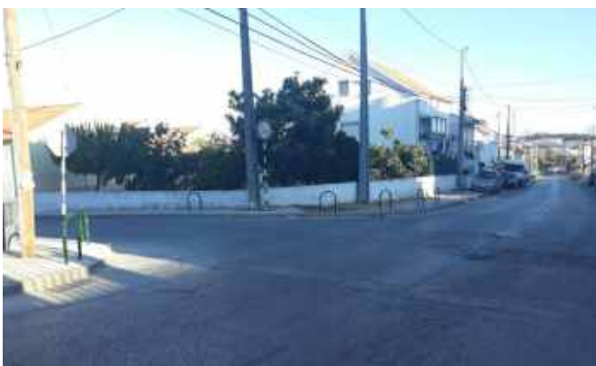
Colocação de pilaretes na rua dos Pinheiros, Pinhal do Vidal
