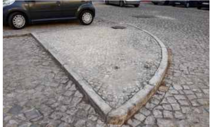
Regularização da calçada na praça João de Deus, Miratejo
