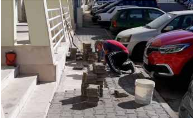
Reparação de calçada na rua Alberto Serpa, Sta. Marta do Pinhal
