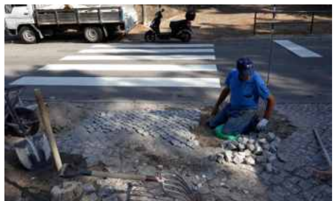
Reparação de calçada no Parque José Afonso, Miratejo
