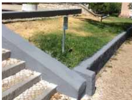
Pintura de muros na Av. Luís de Camões, Miratejo
