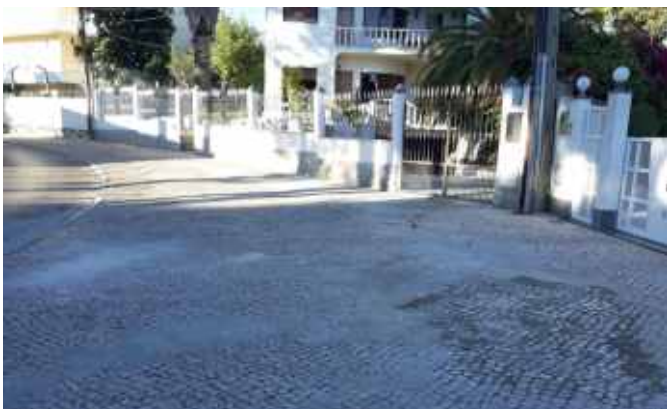
Reparação de calçada na rua Gil Vicente, Miratejo
