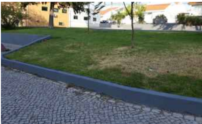
Pintura e reparação de muros, Quinta do Brasileiro
