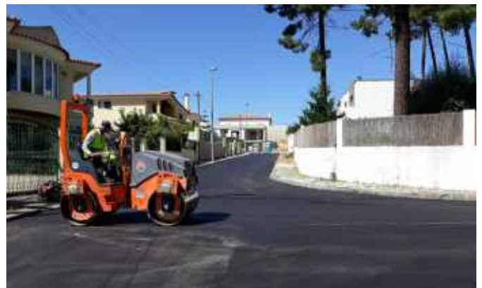
Obras de pavimentação, Verdizela
