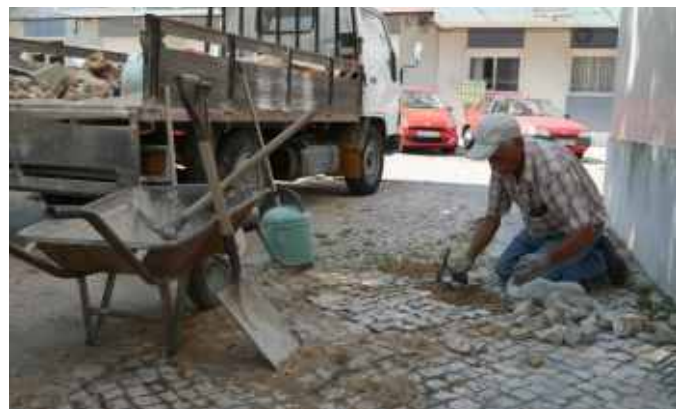
Reparação da calçada, Quinta da Niza
