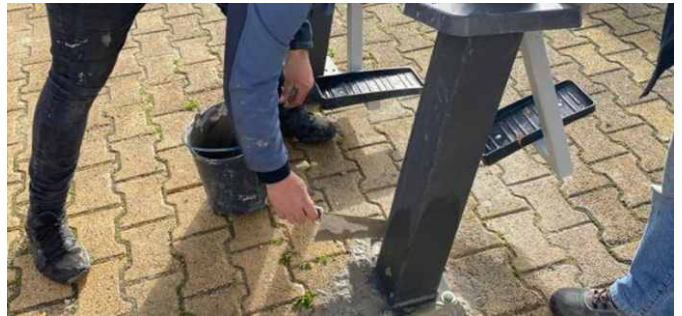
Reparação de aparelhos no jardim de Santa Marta do Pinhal
