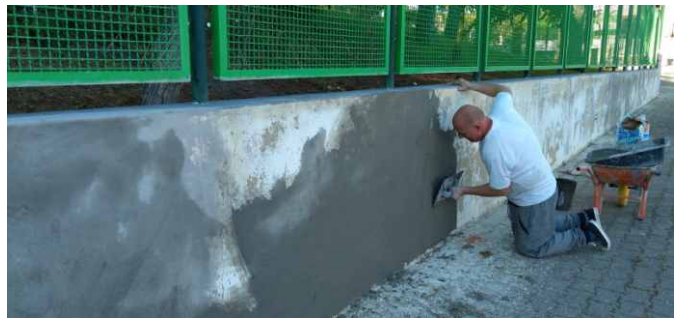
Limpeza, reparação e pintura dos muros da Escola Básica José Afonso
