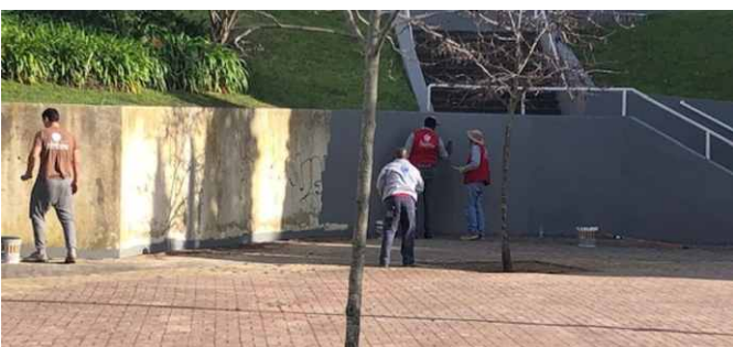
Pintura de muros na Quinta da Marialva
