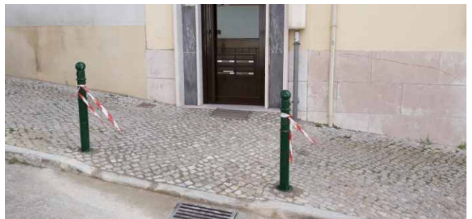
Rebaixamento de passeio na rua Comandante Ramiro Correia
