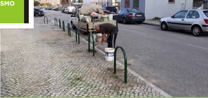
Colocação de pilaretes na rua Cidade de Aveiro - Corroios
